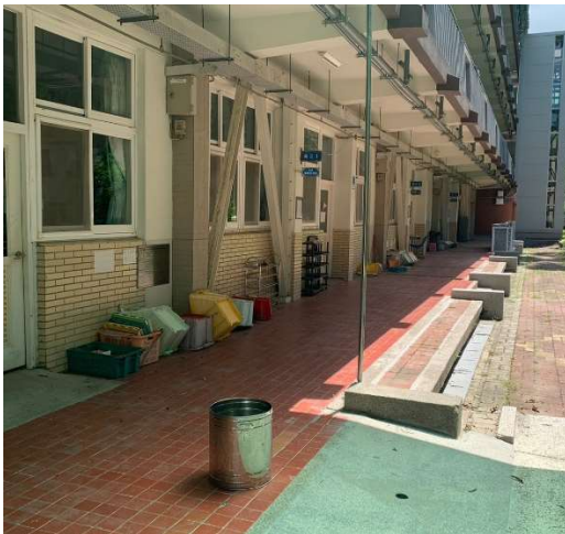
3. 樂群樓 1 樓無障礙坡道
