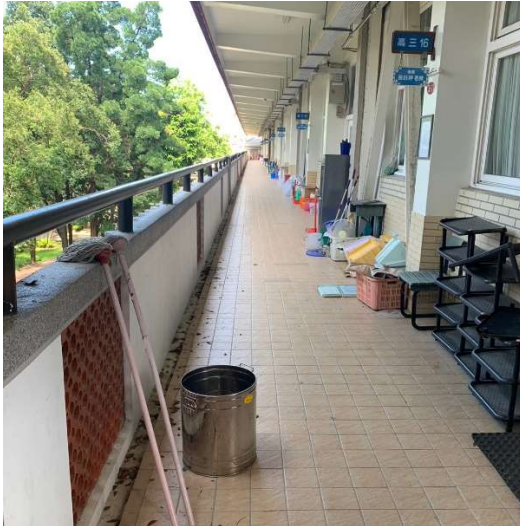
1. 樂群樓 3 樓電梯旁
