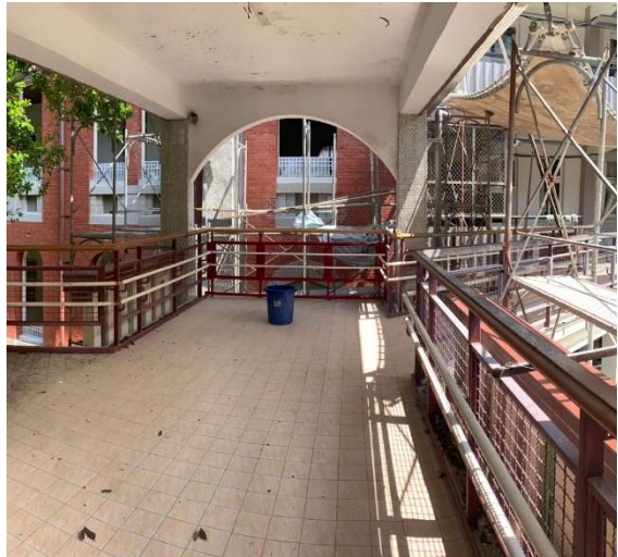
2. 樂群樓、實踐樓 2F 穿廊(*)
