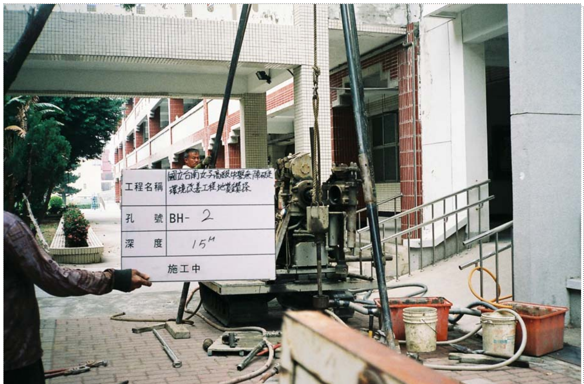
現場施工照片 孔號：BH-2 深度：15.00 M
