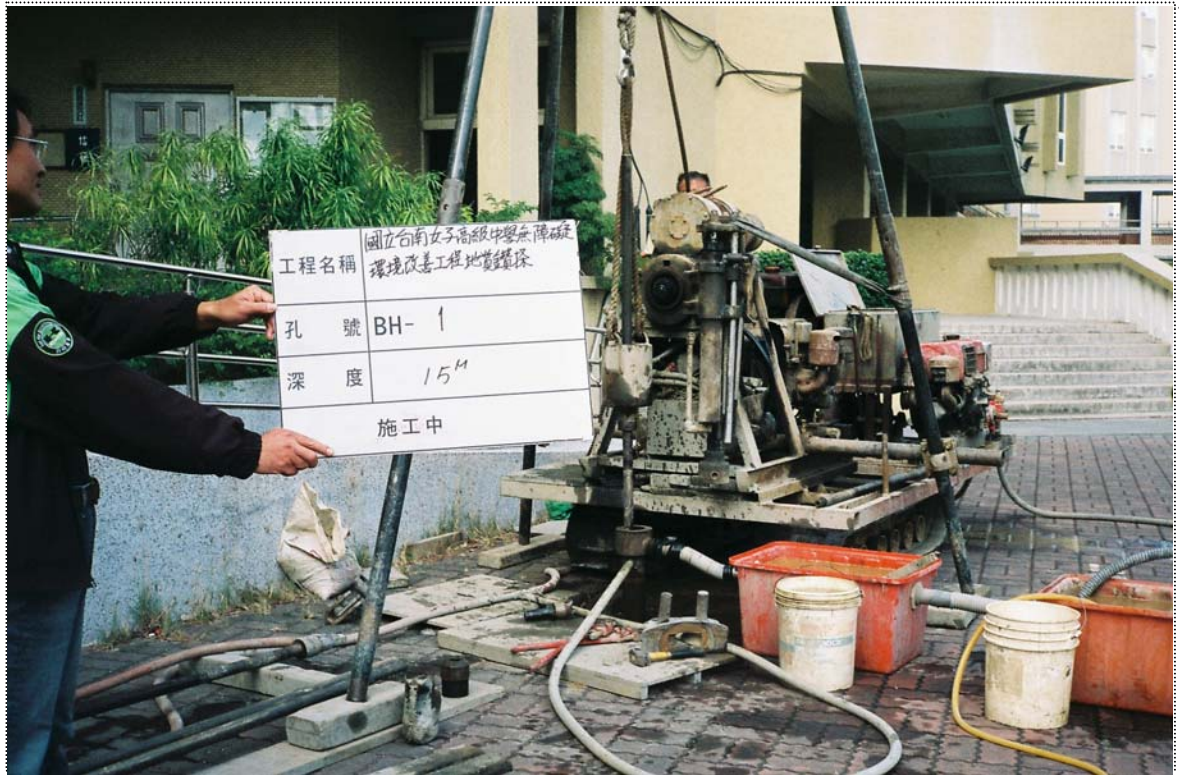
現場施工照片 孔號：BH-1 深度：15.00 M
